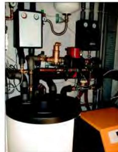
links: Sole-Nachwärmespeicher mit Solaranschluss über Umschaltventil; rechts: mit fertiggestellten Anschluss an Soleleitung über 3-Wege-Mischventil; Fotos: Forum Wohnenergie
