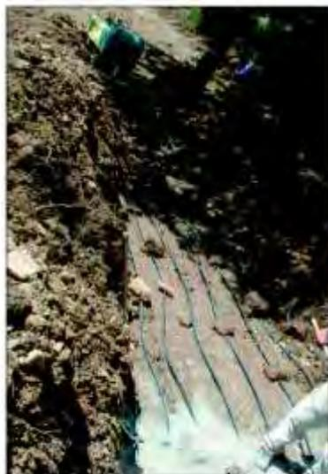
links: Einbringung der Sole-Hauptleitungen in das Haus in versiegelten Bereich, rechts: Ausbildung des Flächen-Erdwärmeabsorbers mit Sandschüttung; Fotos: Forum Wohnenergie
