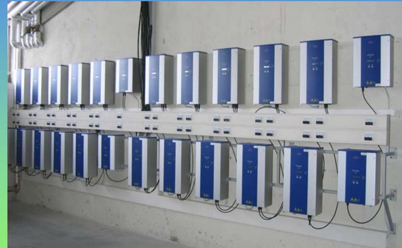
**Wechselrichteranlage 130kWp mit Stromüberwachung**
