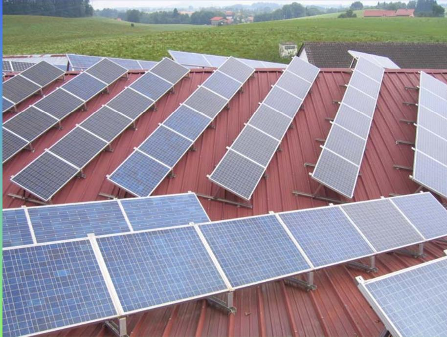
**Firstausrichtung Süd-Ost. Optimaler Einstrahlwinkel durch besondere Modulanordnung**
