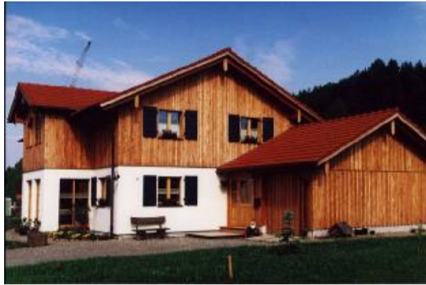
1. Passiv-Einfamilienhaus in Bayern, Holzblockbau
