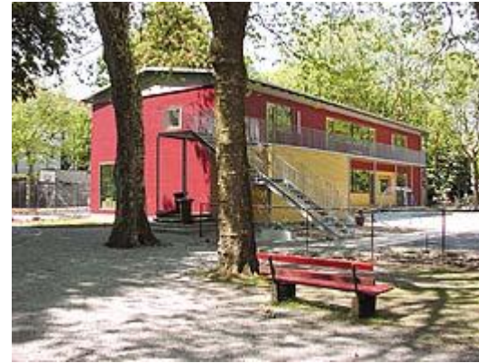
1. Passiv-Kindergarten in Deutschland, Holzrahmenbau
