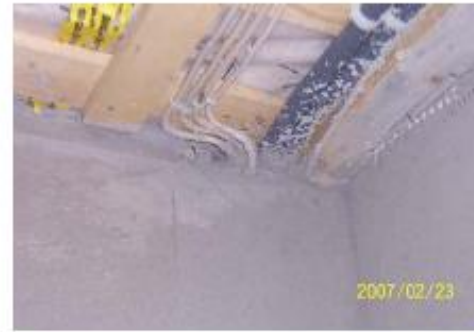
* Kabeldurchführung für den Außentemperaturfühler der WP - Heizung
