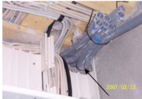
* Kabeldurchführung für den Außentemperaturfühler der WP - Heizung
