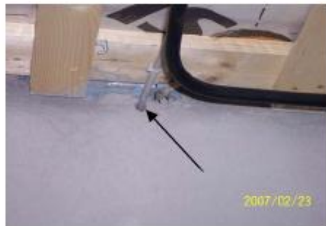
* Kabeldurchführung für den Außentemperaturfühler der WP - Heizung
