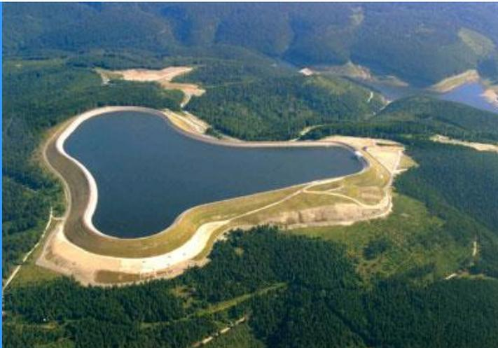
Das größte deutsche Pumpspeicherkraftwerk Goldisthal wurde 2003 in Betrieb genommen und hat eine Gesamtnennleistung von **1060 Megawatt**. Das Kraftwerk kann **8 Stunden** volle Leistung liefern.
