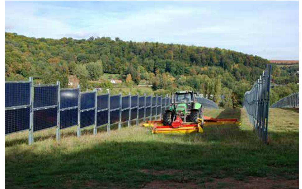
*Quelle: Vertikal errichtete bifaziale Module im Solarpark in Eppelborn-Dirmingen, Saarland mit 2 MWp Leistung, errichtet von Next2Sun. © Next2Sun GmbH*
