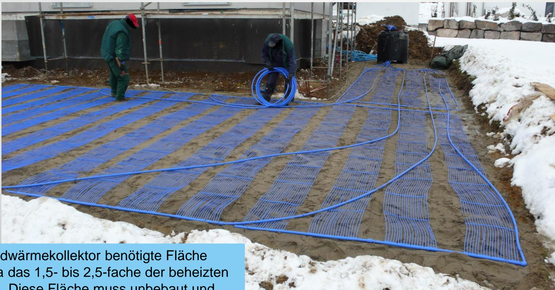
Die vom Erdwärmekollektor benötigte Fläche beträgt etwa das 1,5- bis 2,5-fache der beheizten Wohnfläche. Diese Fläche muss unbebaut und unversiegelt so zur Verfügung stehen, dass in etwa 1,2 bis 1,5 m Tiefe der Erdwärmekollektor verlegt werden kann.
