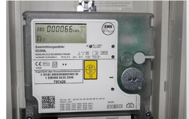
Zweirichtungszähler zählt den aus dem Netz bezogenen und ins Netz eingespeisten Strom.
