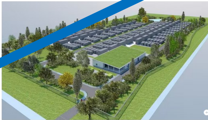
Geplanter Netzbooster in Kupferzell: Mit 250 Megawattstunden Leistung wäre die Anlage die bislang größte der Welt.
