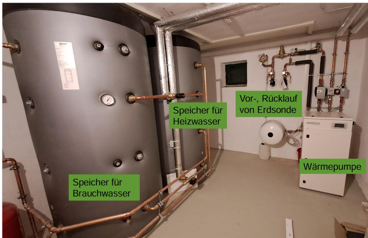
Bild: Komplette Installation am Beispiel einer Wasser-WP (mit Tiefenbohrung) in Privathaushalt (Quelle: Berger/REFI)
