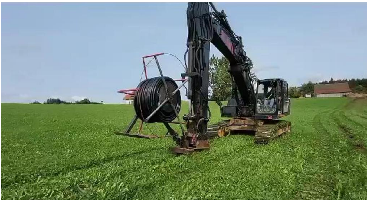
Bild: Einpflügen der Leitungen für eine Kollektorfläche eines Anergienetzes (Quelle: ARWEGO)
