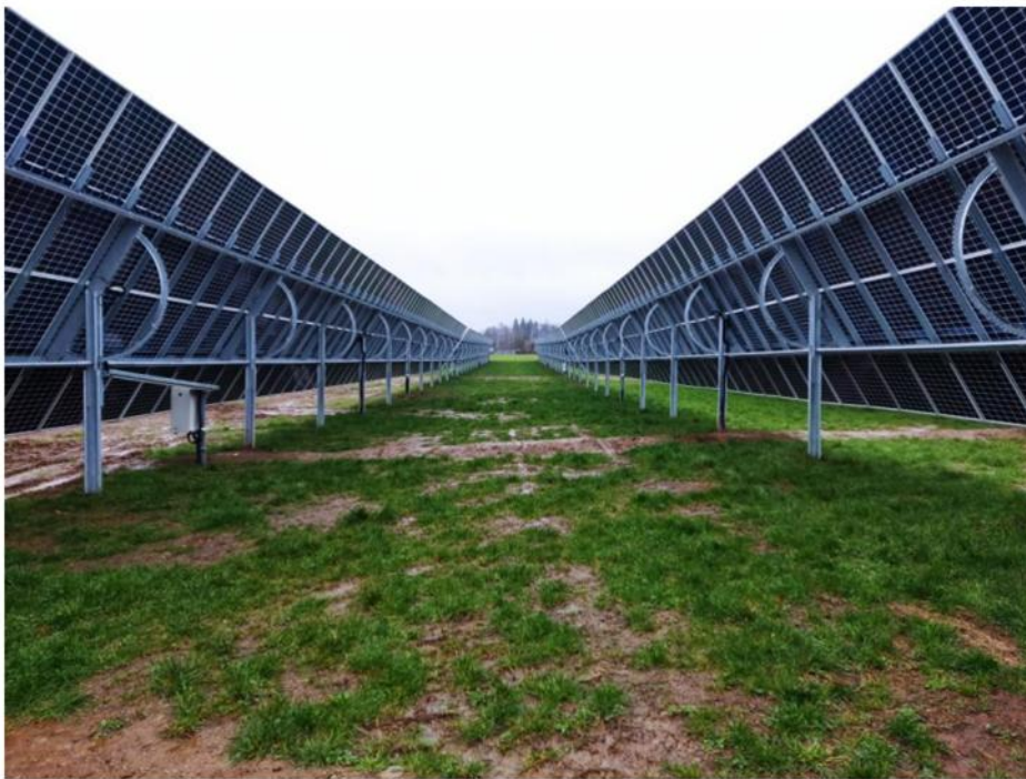
Bild: Agri-PV mit Tracker-System, Quelle: Merlin Batzill, 13. Isnyer Energiegipfel 2024
